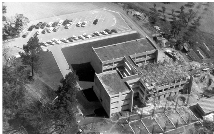
Unidad Córdoba (Veracruz), en construcción.
